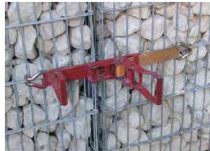
4. Mit speziellem Zurrurt zusammenziehen
