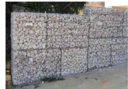
9. Fertige Steinkorbmauer
