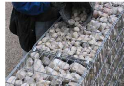
6. Deckel mit Klammern verbinden und bis zur Koroberkante mit 16/32 Gfrobsplitt auffüllen
