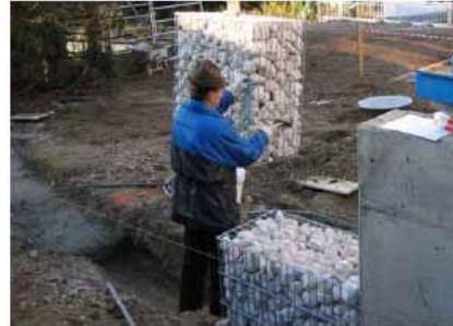
2. Vorstehende Steine an den Anschlussseiten flachklopfen
