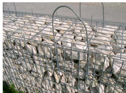
Durch integrierte unscheinbare Hebeseile im Korbinneren ist es jederzeit möglich, den Steinkorb wieder zu entfernen bzw. neu zu versetzen.
