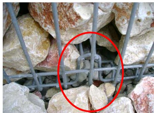
Ebene unscheinbare Auflagerfläche durch speziell gebogene Gitterelemente.
