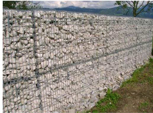
Durch eine gleichmäßige Maschenanordnung, aufgrund eines stabilen Doppelstabsystems (=weniger sichtbarer Stäbe), liegt das Augenmerk mehr auf der Füllung als auf den Gitterstäben.
