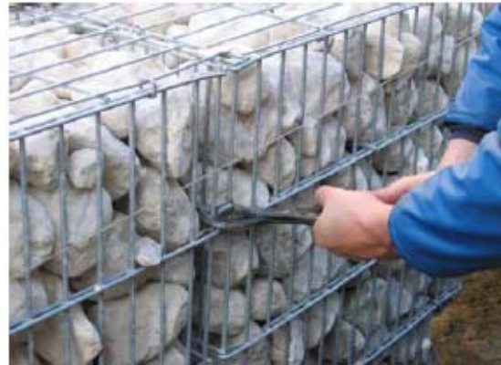
5. seitlich mit Klammern verbinden (die Klammern werden oberhalb eines Querstabes gesetzt)
