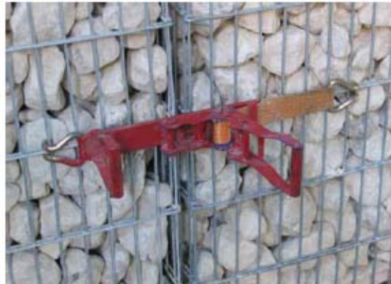
4. mit speziellem Zurrgerät zusammenziehen
