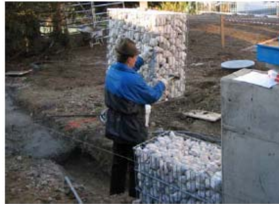
2. vorstehende Steine an den Anschlussseiten flachklopfen
