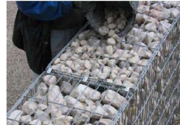
6. Deckeln mit Klammern verbinden und bis zur Korboberkante mit 30/50 Zierkies auffüllen. (Wichtig)
